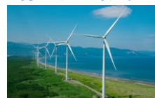
風力発電施設
