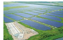
太陽光発電施設
