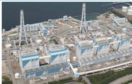
碧南火力発電所
