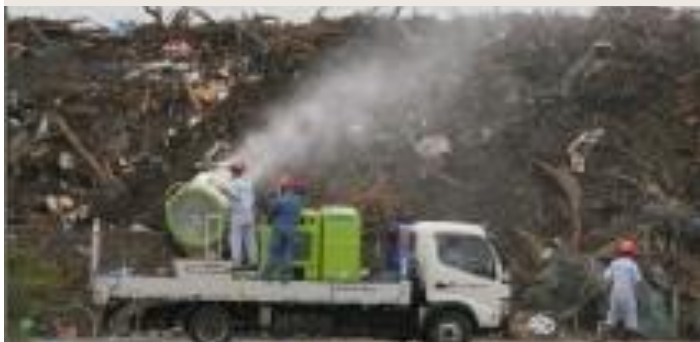
スパウターによる消臭作業
