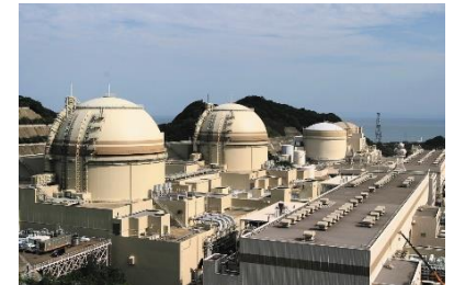
原子力発電所
