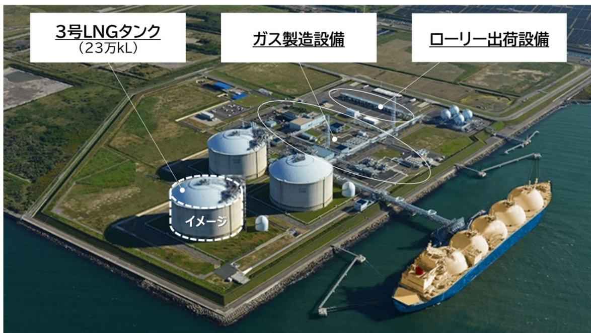
[ひびきLNG基地能力増強完成イメージ図]
