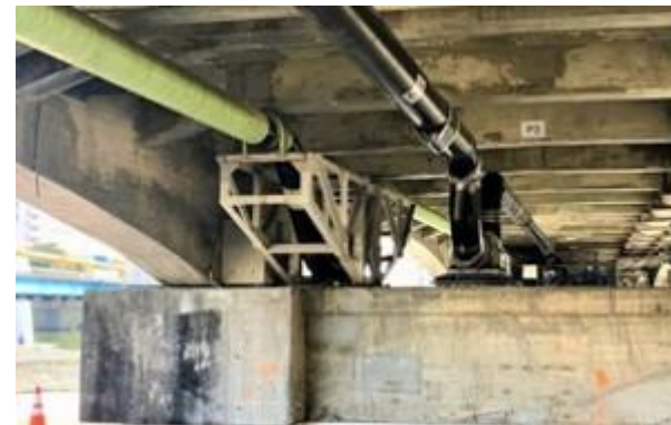
高圧導管 (架管入替／補強工事など)
