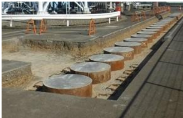
清水エル・エヌ・ジー(株)袖師基地 (側方流動対策工事など)
