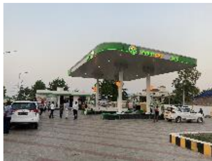
バイオCNGスタンド
